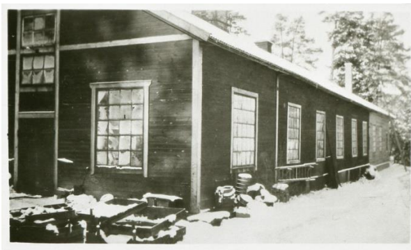
Gjuteriet. Närmast i bild låg kärnmakeriet och längst bort var efterbehandlingen i rensboden där det även fanns ett litet kontor. I det stora utrymmet däremellan arbetade gjutarna med gjutformar och flaskor. Golv saknades i gjuteriet och backen var täckt med sand för att minska brandrisken. Foto från kommunens bildarkiv.
