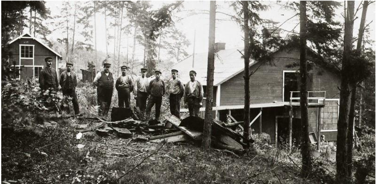
Ett tidigt foto (enligt olika uppgifter 1905 resp 1907), med arbetsstyrkan uppställd framför gjuteriet till höger och modellverkstaden till vänster. Gjutmästaren Axel Ryd är trea från vänster, till höger om honom står Oscar Sundblad och trea från höger August Pettersson. Foto från kommunens bildarkiv.
