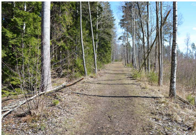
Från dagens Enköpingsvägen på Stäksön fram till Dalkarlsbackens krön är ca 400 m av 1600-talsvägen väl bevarad. Vägen är 4-5 m bred och vägbanken upp till 80 cm hög. Foto författaren 2012.
